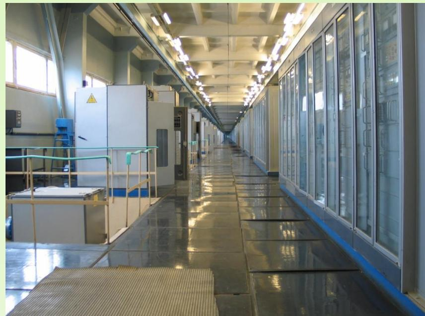
**Галерея ВЧ питания основной части ускорителя**
