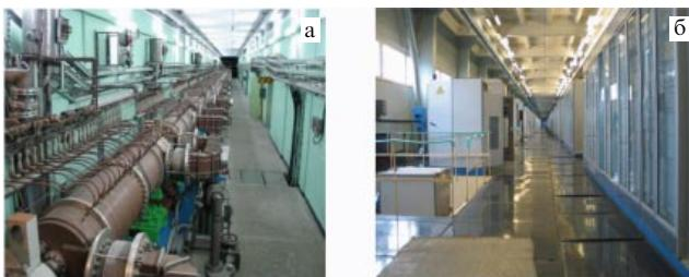
**Фото 8.** Ускоряющие резонаторы (а) и галерея ВЧ-питания (б) основной (600 МэВ) части ускорителя.
