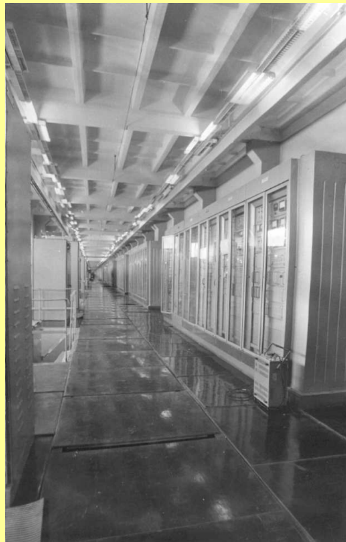
Галерея ВЧ питания основной части ускорителя
