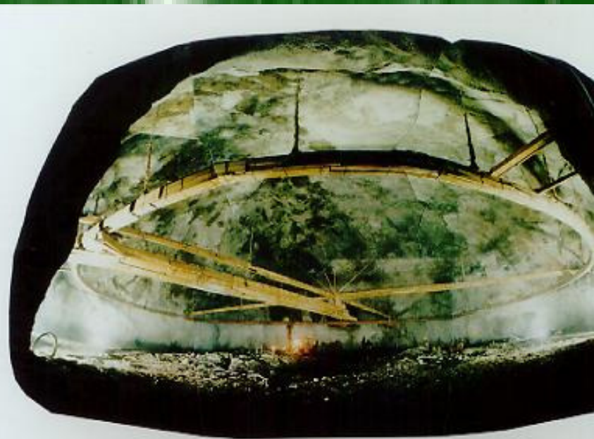
水槽上部(天井ドーム部) の完成状況 平成18年 8月 2日 撮影(アレーナ引込レーン部から撮影)
