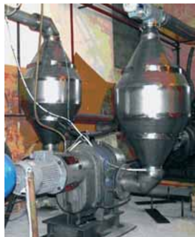
Рис. 3. Вакуумный насос типа 2ДВН500 с промежуточными теплообменниками «разреженный гелий-вода».
