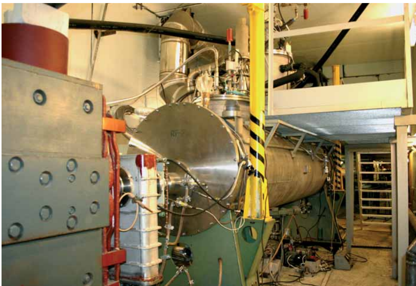
Рис. 8. Сверхпроводящий ВЧ-резонатор RF2 в канале.
